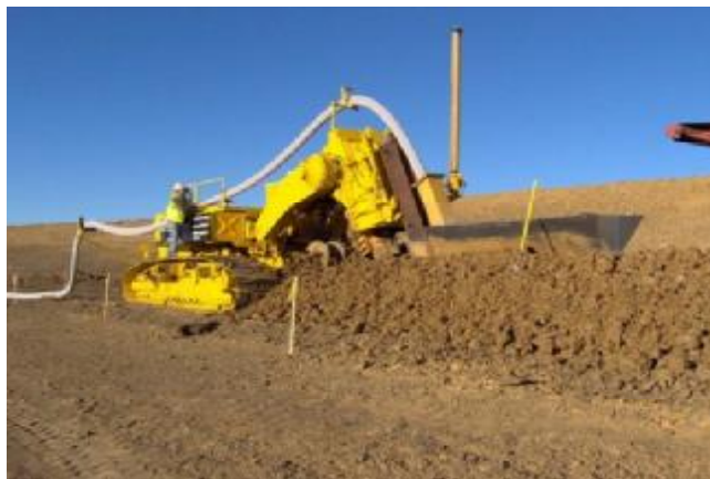
Obr. 1.1.10: Pásový ryhovač pri vkladaní kábla do zeme
