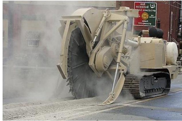
Obr. 1.1.15: Ryhovač TESMEC TRS - 1000 pri rezaní asfaltového behúňa
